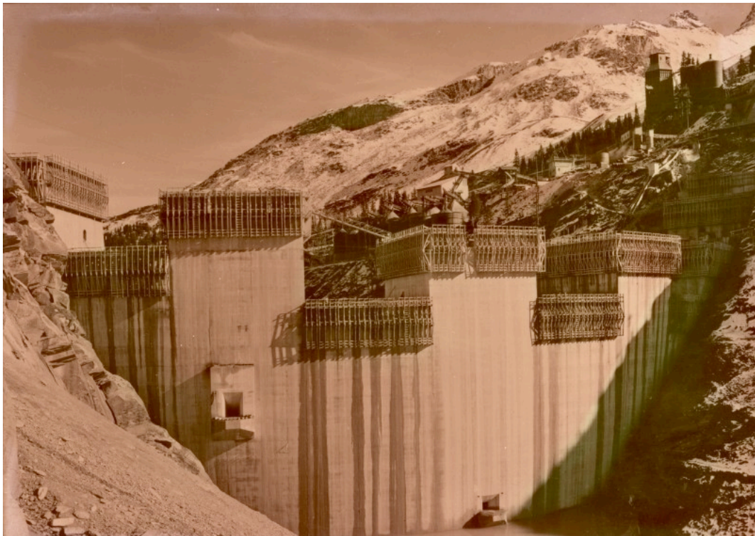
Bau des Zeroreilastaudamms (J. Geiger)
